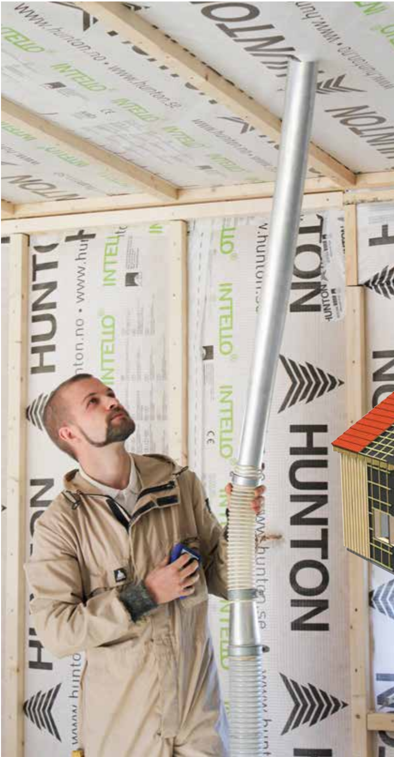
Illustrationen viser væg blæseisoleret, med Træfiberisolering.
