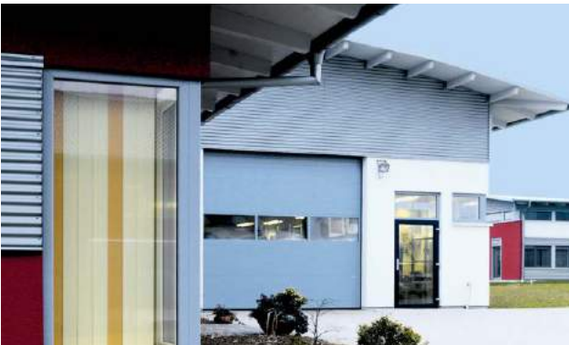
Hal-/kontorareal: 300/200 m² | Byggeperiode: 18 dage
